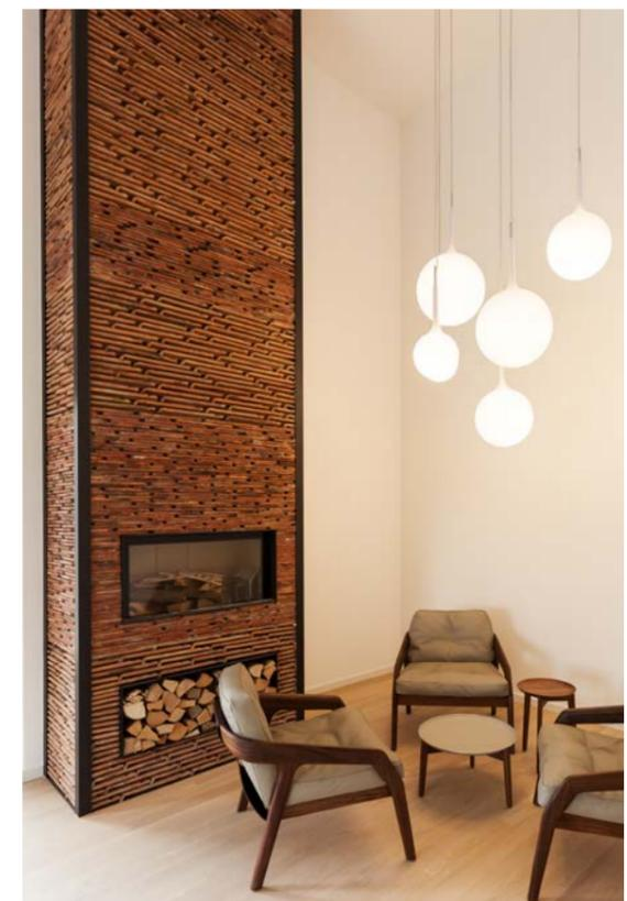
Alte Dachziegel dienen als Wärmespeicher für den Ofen.
